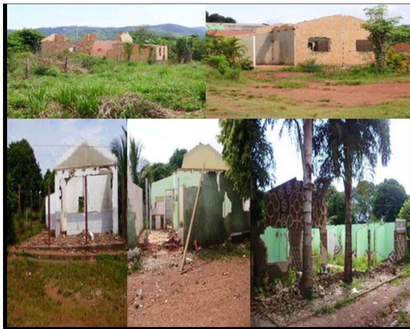
Imagem 18: Imagem com casas em demolição na Vila Racha Placa Fonte: Arquivo da autora.
