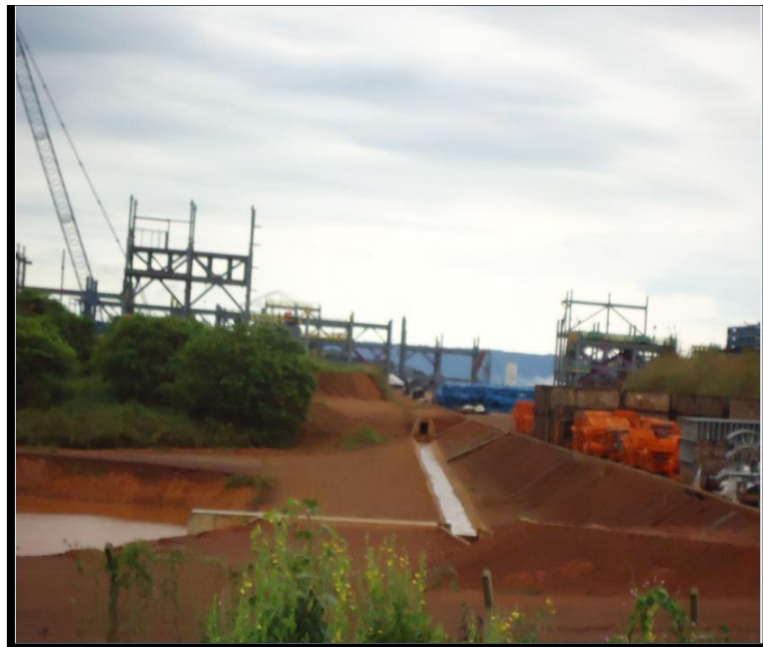
Imagem 05: Aspectos do canteiro de obras do Projeto S11D em meados do ano de 2013.
