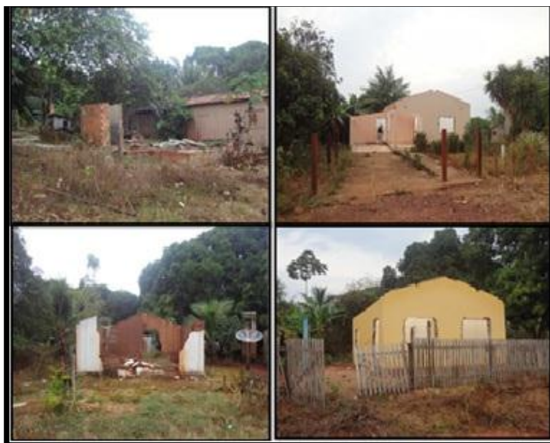
Imagem 19: Imagem com casas em demolição na Vila Racha Placa Fonte: Arquivo da autora.
