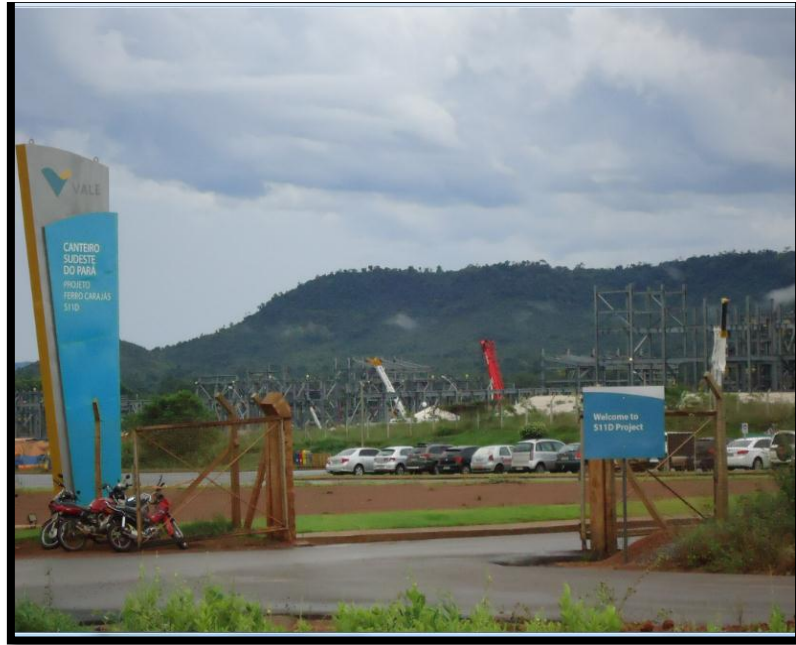
Imagem 06: Aspectos do canteiro de obras do Projeto S11D em meados do ano de 2013.
