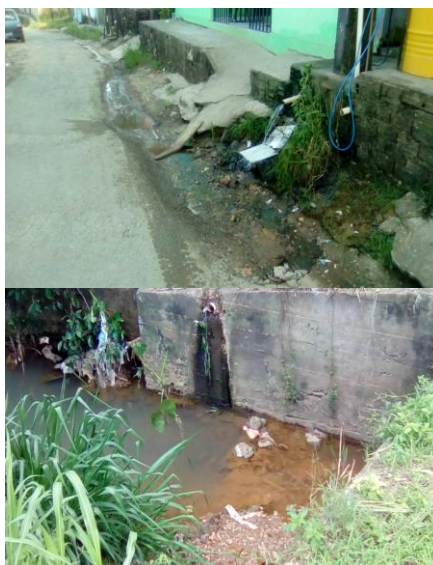
Imagem 21 - Esgoto escorrendo a céu aberto no bairro Amapá.
