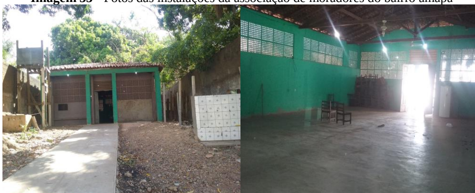
Imagem 33 - Fotos das instalações da associação de moradores do bairro amapá
