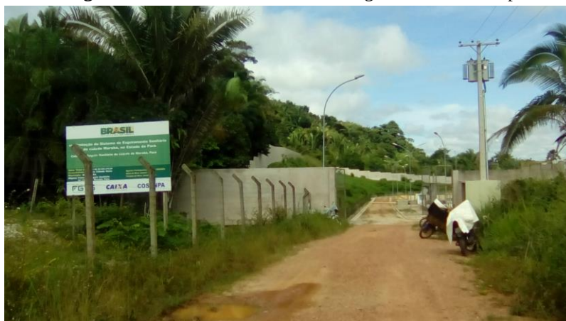
Imagem 19 - Central de tratamento de esgoto no bairro amapá
